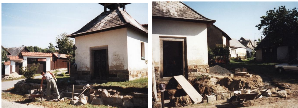
Práce na opravě kapličky v roce 2003
