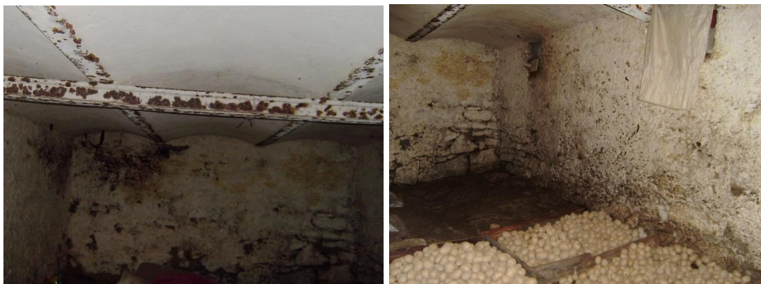
Pohled do sklepa č. 14 (U Kalců), do kterého se brambory sypaly z průjezdného mlatu stodoly.
