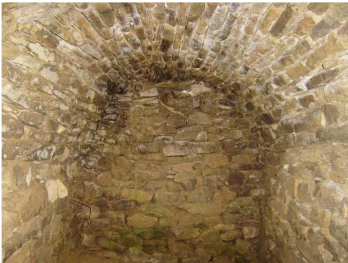
Vyzdění a klenba „ Krejčova sklepa “ č. 1 (lochu) patří k nejlépe dochovaným zdejším sklepům. V zadní stěně nahoře je vidět násypný otvor.
