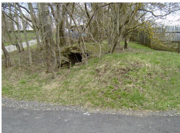
Pátý z venkovních sklepů (lochů), „ Košákův sklep “ č. 24, na rozdíl od 4 předchozích sklepů nemá kulatou klenbu, ale je překryt masivními kamennými pláty, nad kterými je navršen kopec hlíny. Vzadu opět vidíme násypný otvor.
