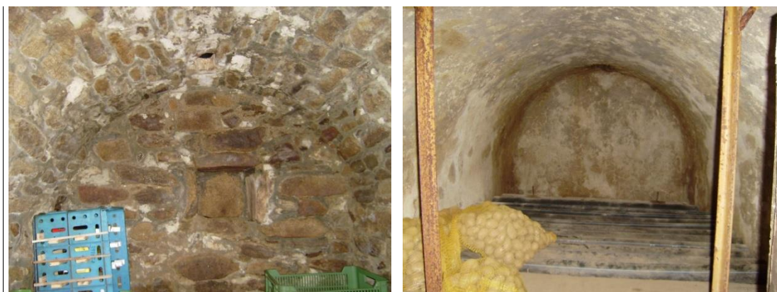
Pohled do starého „zapomenutého“ sklepa č. 13 (U Hvíždů) – první snímek. Další sklep využívají majitelé č. 13 k uskladnění brambor, klenba je oházená a sklep vybílen.
