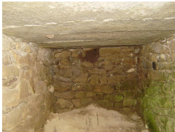
Pátý z venkovních sklepů (lochů), „ Košákův sklep “ č. 24, na rozdíl od 4 předchozích sklepů nemá kulatou klenbu, ale je překryt masivními kamennými pláty, nad kterými je navršen kopec hlíny. Vzadu opět vidíme násypný otvor.
