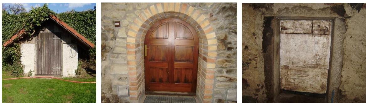
Vnější vchody do sklepů - u č. 14 se stříškou, ozdobný vchod u č. 15 a východ z vnitřku sklepa č. 10, kde v kamenném ostění jsou zabudované vnitřní dveře s izolačními deskami.
