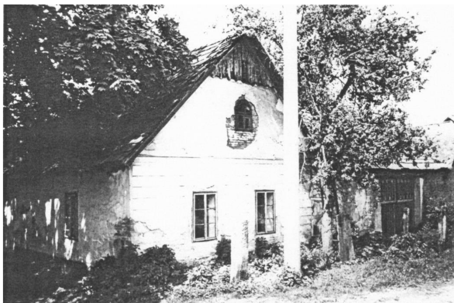
Č. 9 U Výborných (stavení už neexistuje)
