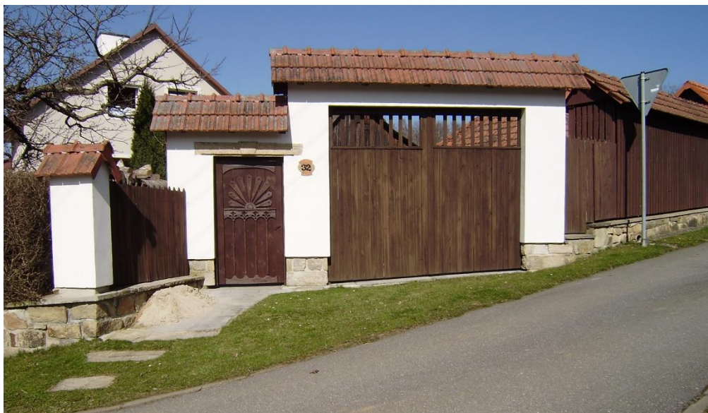
Nově upravený vjezd a vchod do domu č. 32 se vsazenými renovovanými dvířky
