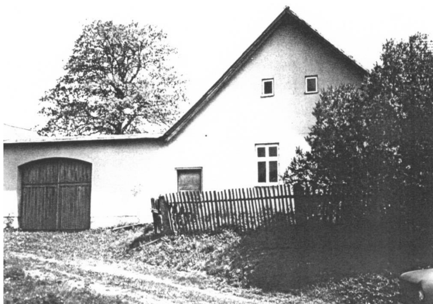
Č. 19 U Přenosilů, stará část s dvířky zůstala, vrata připadla k č. 34, nahrazena novými
