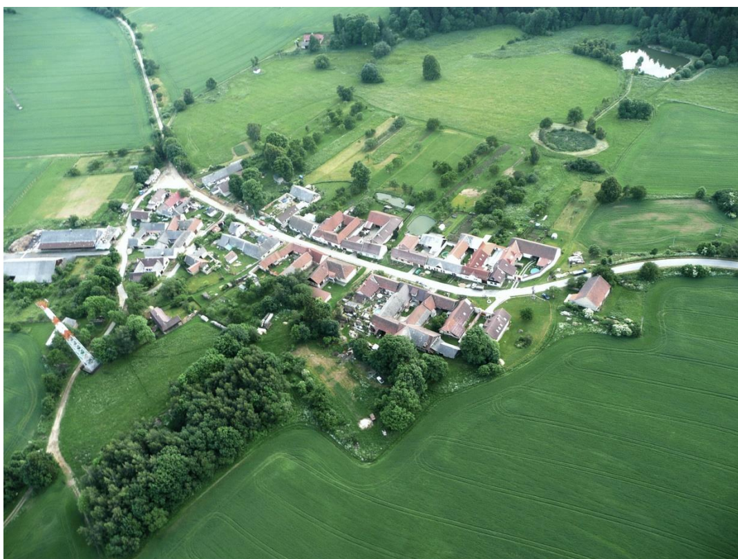
Silnice procházející obcí a pohled k čističce u Jankovského potoka (foto M. Váňa 2009)
